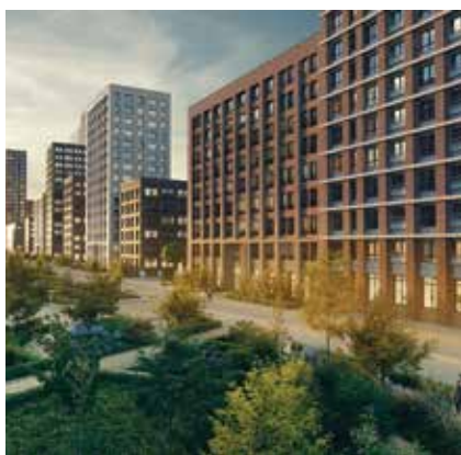
ЖК Домашний (СУ-10 ФУНДАМЕНТСТРОЙ)
